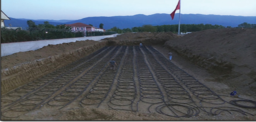
Şekil 23. Toprak Kaynaklı Isı Pompası Kaynak Boru Döşeme
