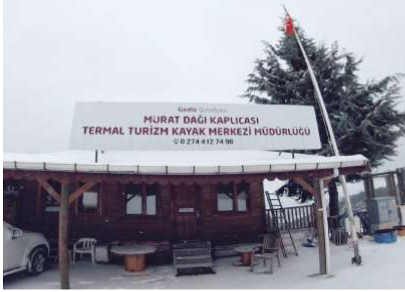
Şekil 2. Murat Dağı Termal Kayak Merkezi Yönetim Binası
