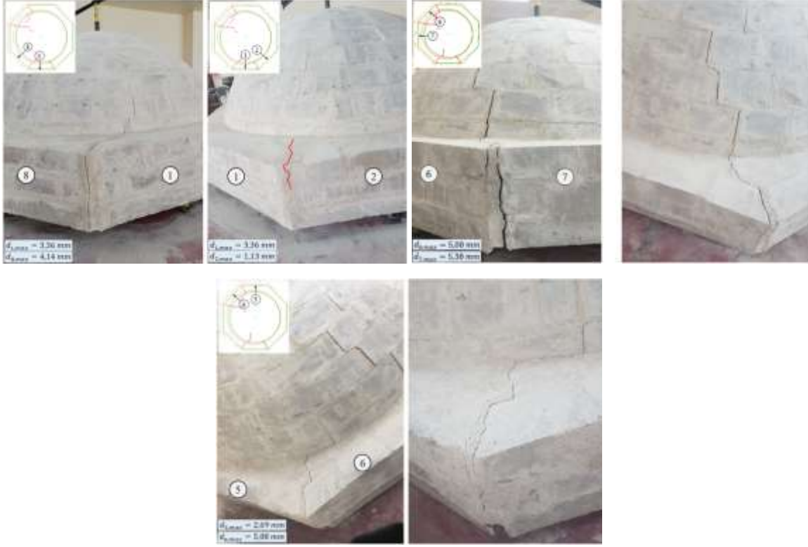
Şekil 2. Eref Numunesi Üzerinde Oluşan Çatlaklar
