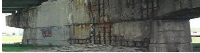
Şekil 2. Paslanan Donatı Betonu Çatlatır
