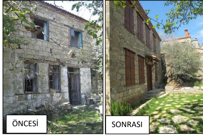
Şekil 14. Restore Edilmiş Bir Evin Önce ve Sonra Cephe Görünümü (Güzin Kutlu Arşivi, 2020)
