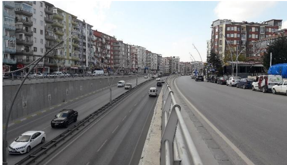
Görsel 2. Uşak Merkez'den geçen E96 Karayolu
