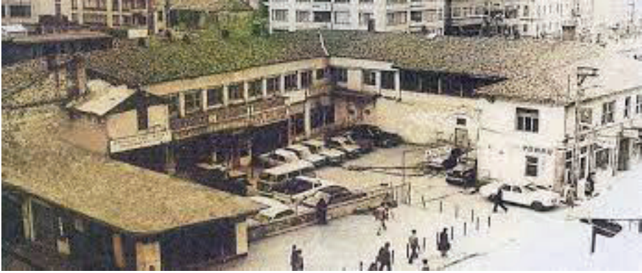
Şekil 8. Yıkılan Tarihi Suluhan Binasının Özgün Hali (URL-6)
